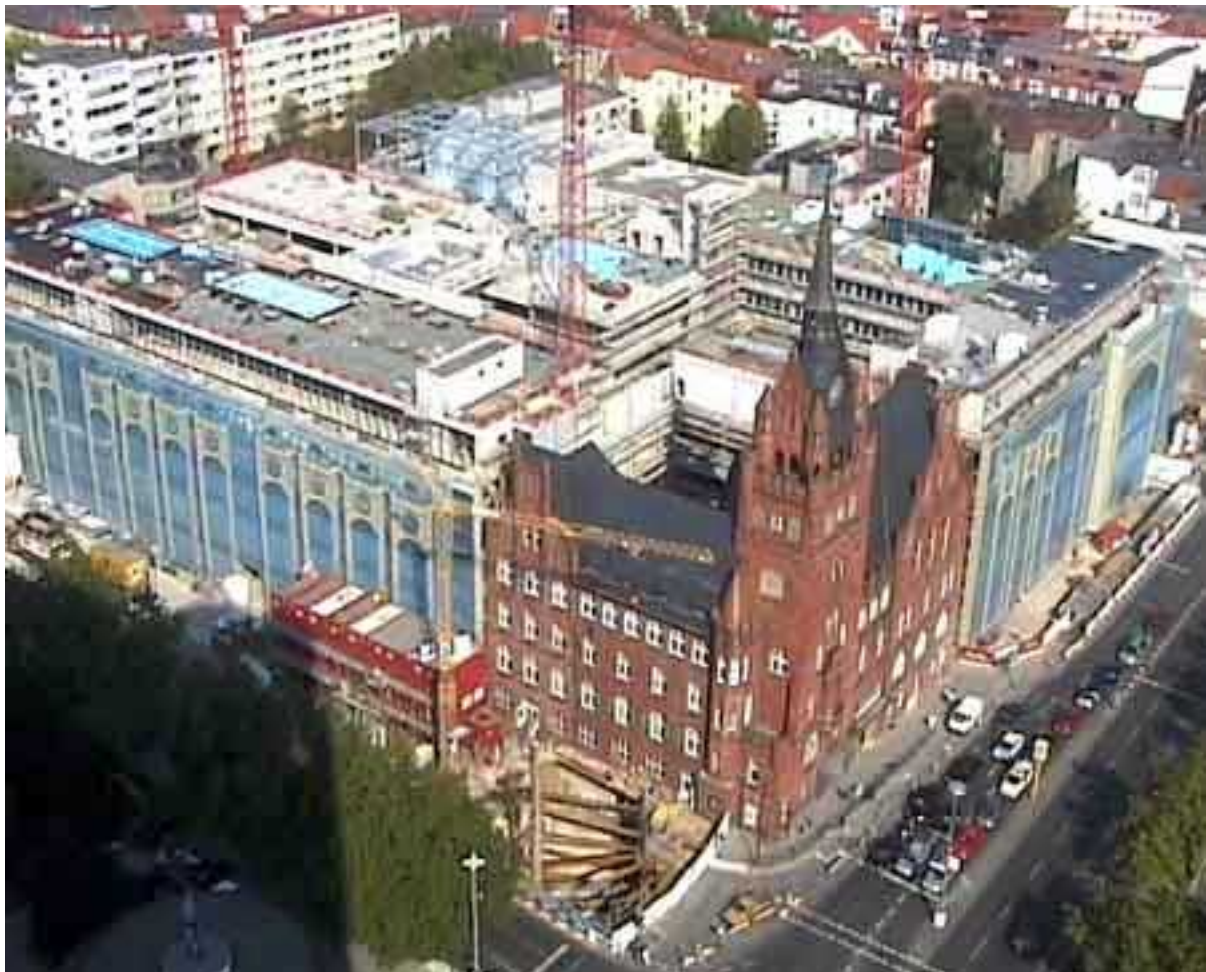
Baustelle des Einkaufszentrums „Das Schloss“ am Rathaus Steglitz, Foto: www.das-schloss-steglitz.de
